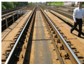
Рис. 1. Безбаластне мостове полотно із залізобетонних плит: а – загальний вигляд; б – конструкція: 1 – плита БМП; 2 – контруктник; 3 – рейка; 4 – верхня полка подовжньої (головної) балки прогонової будови; 5 – армована гумова стрічка прокладного шару; 6 – дерев'яна дошка прокладного шару; 7 – високоміцна шпилька; 8 – отвір в плиті для високоміцної шпильки
