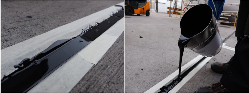
Рис. 2. Герметизація швів за допомогою Sikaflex®-406 КС
