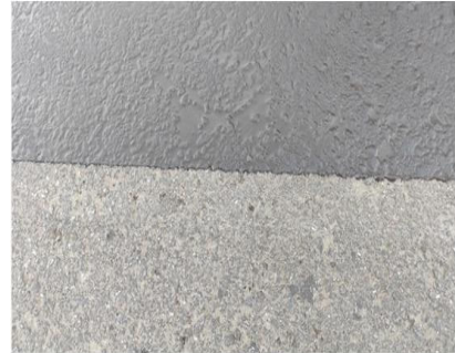
Рис.3. Приклад старого асфальтобетону (внизу) та відремонтованого (вгорі)
