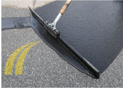
Рис.2. Влаштування ультратонкого покриття вручну
